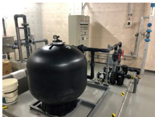
本社にある雨水のろ過システム
