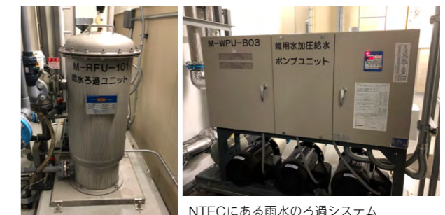
NTECにある雨水のろ過システム
