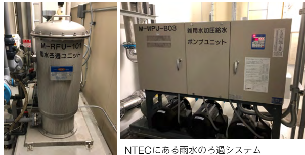
NTECにある雨水のろ過システム
